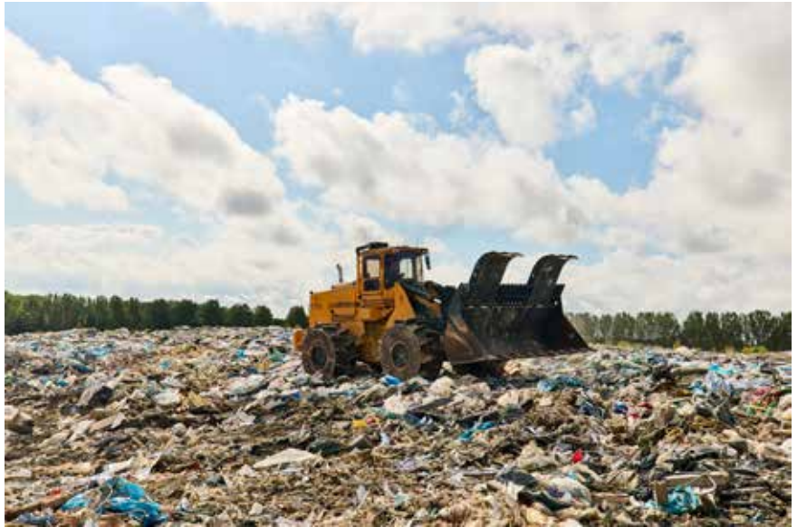
Regnvand, der siver ned gennem affaldet på et deponi, kaldes for perkolat. Perkolatet opsamles fra membraner i bunden af deponiet og pumpes op. Herefter sendes det til rensning på det kommunale rensningsanlæg. Hvis indholdet af PFAS overstiger grænseværdierne, skal det renses først. Derfor har vi nu et forretningsanlæg på Faxe Miljøanlæg og håber snart at kunne etablere ét på Forlev Miljøanlæg også.
