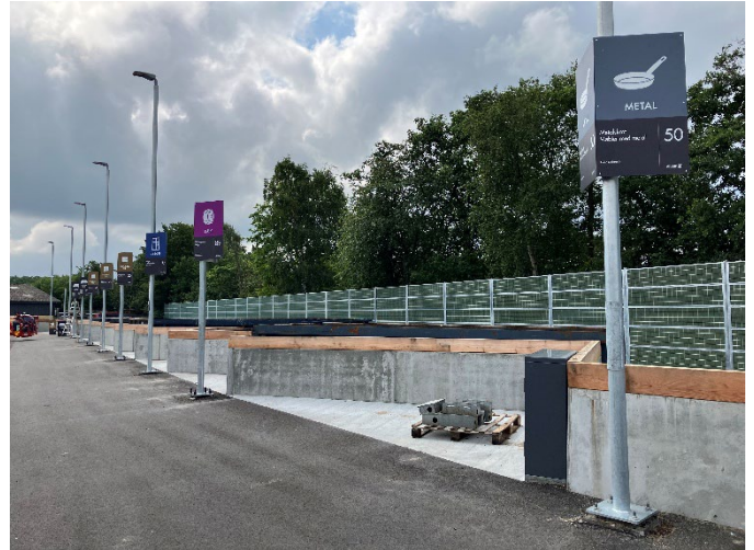
Den ombyggede genbrugsplads byder bl.a. på nedgravede containere, som gør det nemmere at aflevere tunge affaldstyper.
