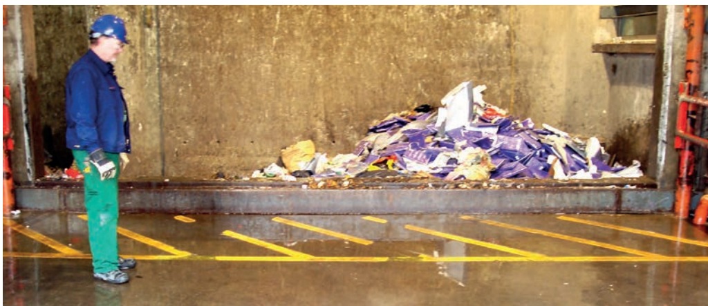
Når bommen er åben, må du IKKE opholde dig i området ved silokanten, dvs. hvor der er afmærket med gult.
